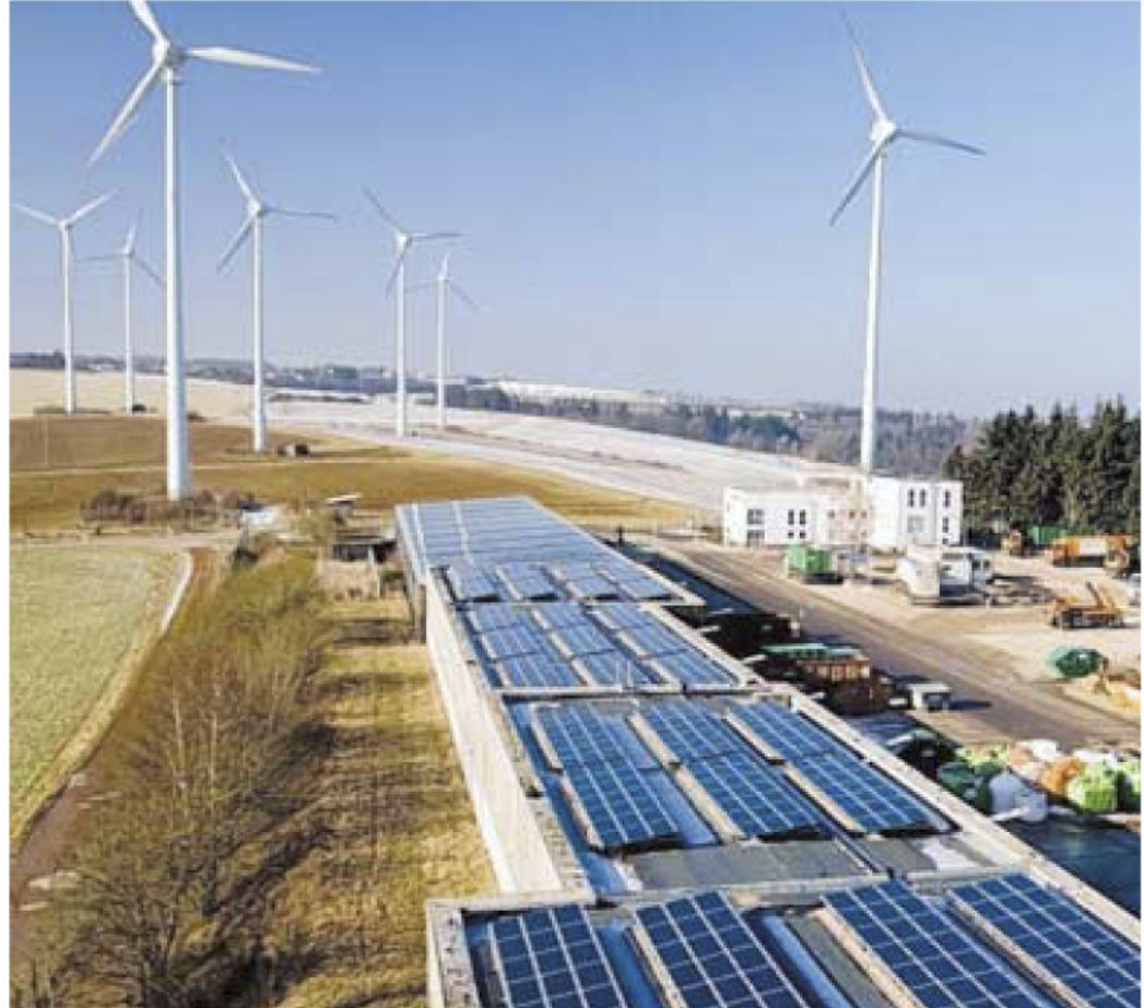
20-Millionen-Projekt in Kemel: Dort sollen pro Jahr 32 Millionen Kilowattstunden Strom und mehr als 25 Millionen Kilowattstunden Wärmeenergie produziert werden.
